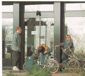
La pose du film de sécurité Scotchshield™ a permis de rendre ce vitrage conforme aux normes de sécurité en vigueur.
