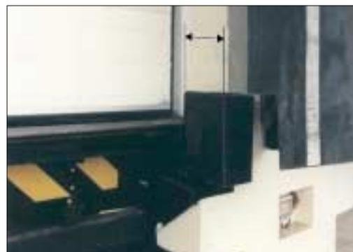
Photo 3.5 Vue sur butoir assurant un espace de 500 mm devant le mur du quai et devant la rampe ajustable en position de repli.
