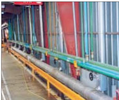
Photo 5.2 Fluides. Système de couleur pour le repérage des circuits des différents fluides.
