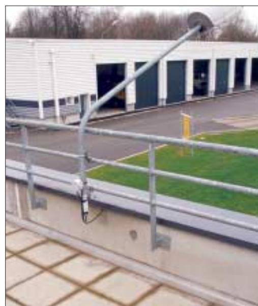
Photo 5.1 Luminaire pivotant facilitant le remplacement d'ampoule.
