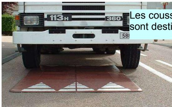
Les coussins Berlinois en caoutchouc vulcanisé, avec armature métallique, sont destinés à être utilisés dans les zones 30.
